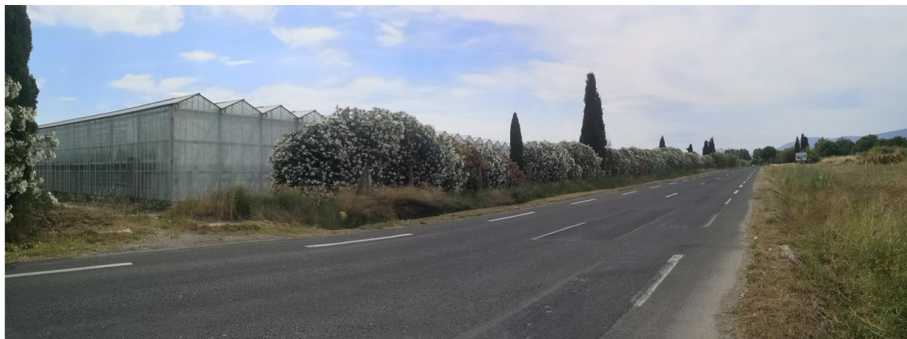
Photo 2 : Vue vers le sud des serres existantes depuis la RD22 (source étude d'impact)
